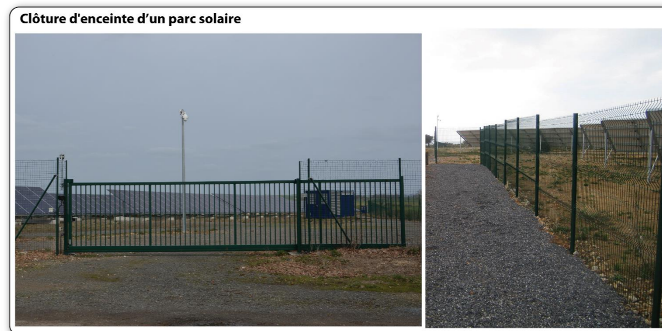
Figure 4 : Clôture de sécurité
